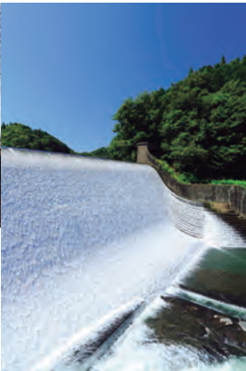
右岸はしなやかな円弧、左岸は階段状の石組みが特徴的。非対象の建築構造が、水流の演出効果をさらに高めている
