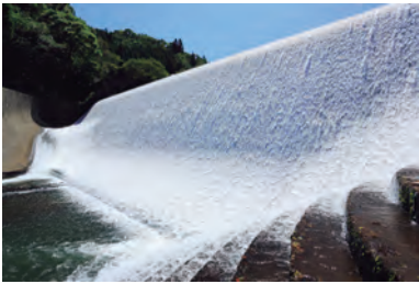
右岸はしなやかな円弧、左岸は階段状の石組みが特徴的。非対象の建築構造が、水流の演出効果をさらに高めている
